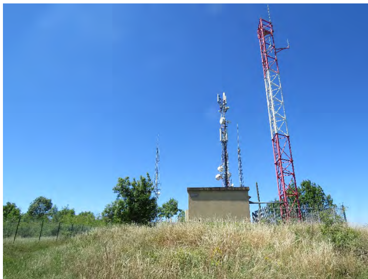
Figure 15 : Éléments paysagers du secteur du projet – Émetteurs du Puy-de-Mur
